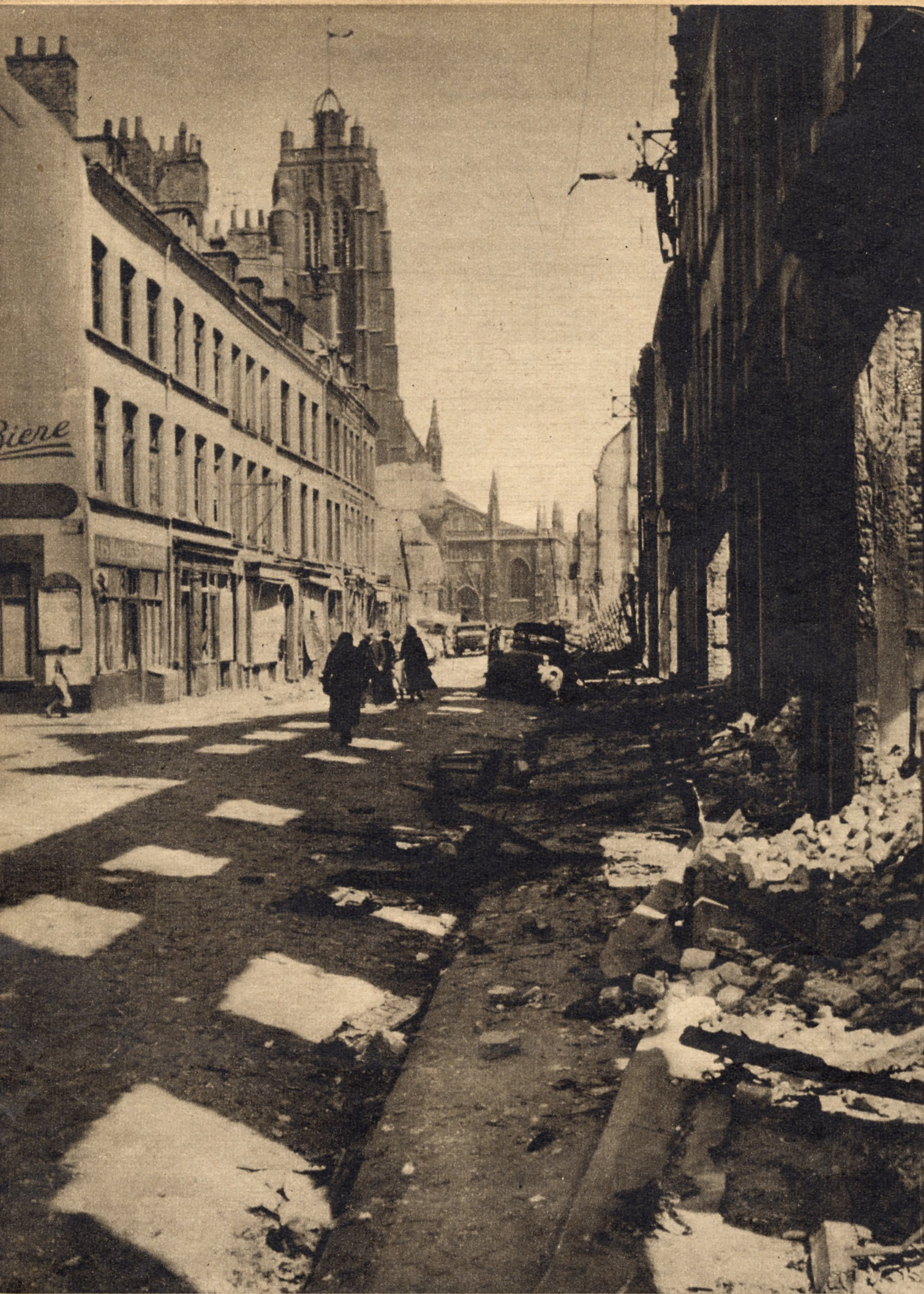
So sehen in Dünkirchen die Straßen aus, und diese ist noch eine von denen, die wenigstens passierbar sind. Die leeren Häuserfronten zeichnen bizarre Schatten auf das mit Glassplittern übersäte Pflaster
